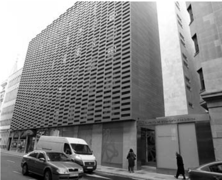
Edificio de la Hacienda foral, en la calle Arrieta.
