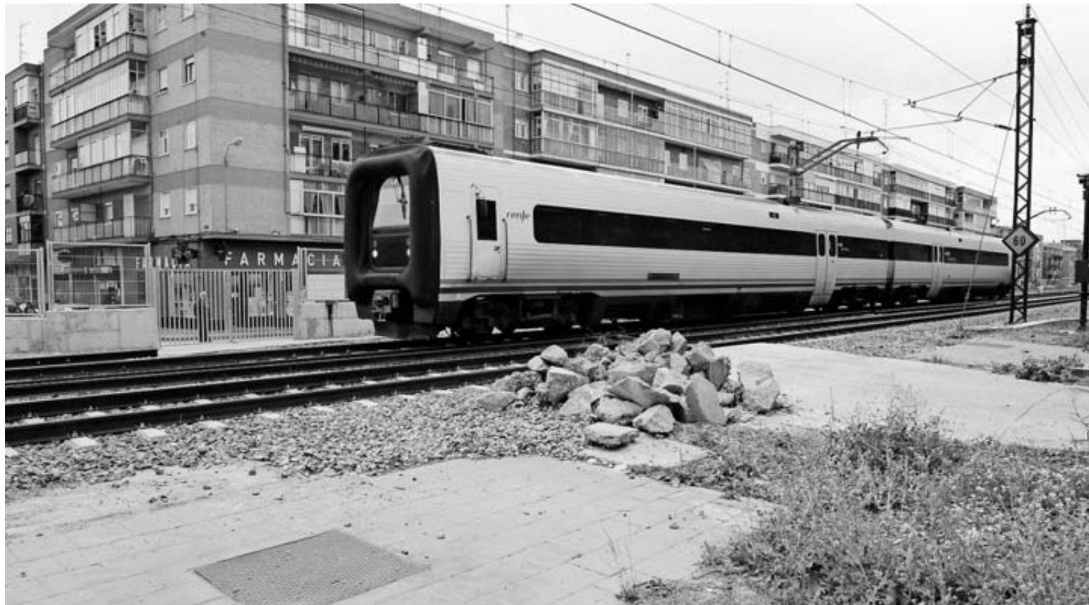
Labores de mantenimiento en el trazado del AVE que pasa por uno de los barrios de Valladolid.
