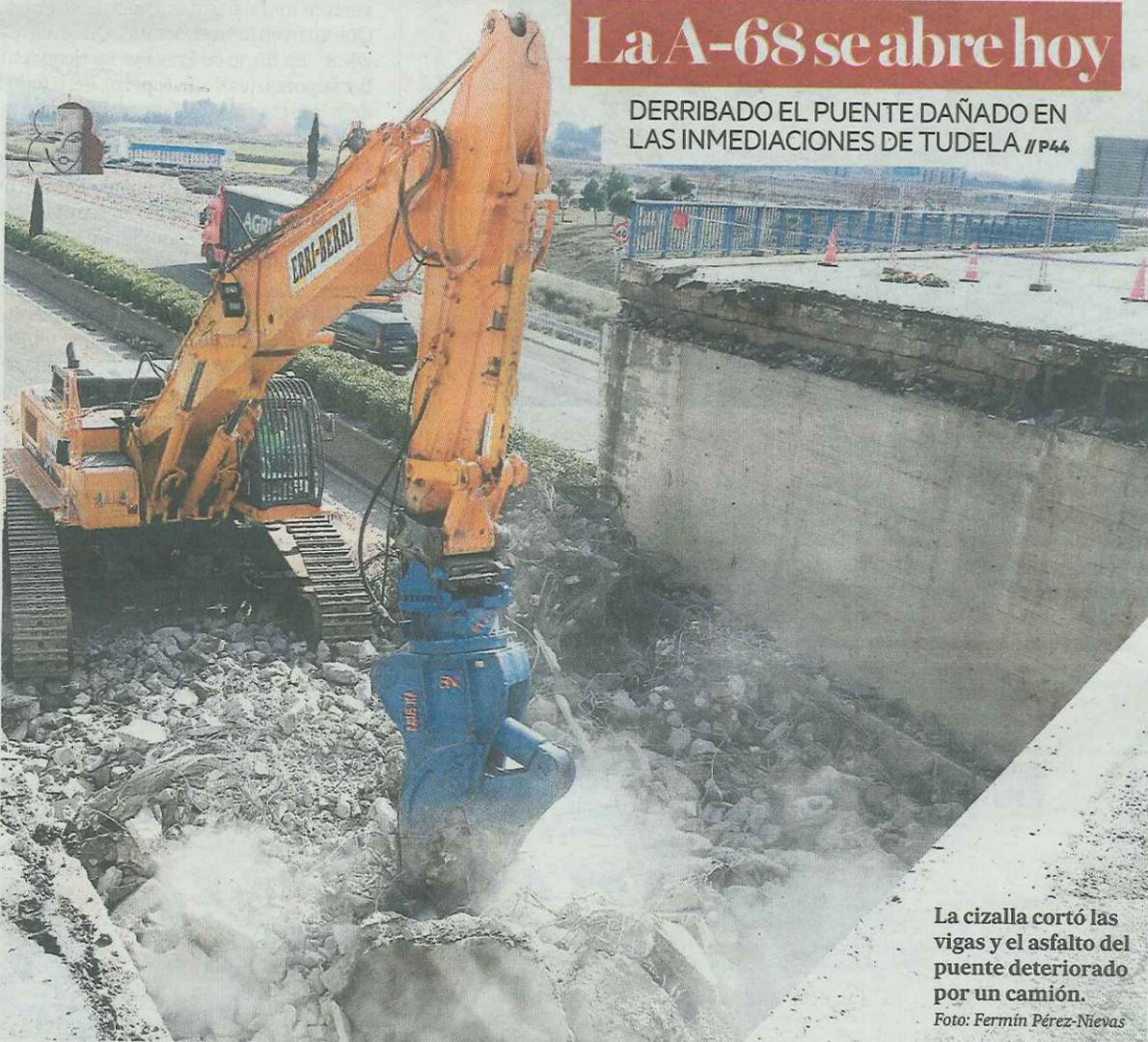
La cizalla cortó las vigas y el asfalto del puente deteriorado por un camión. Foto: Fermín Pérez-Nievas
