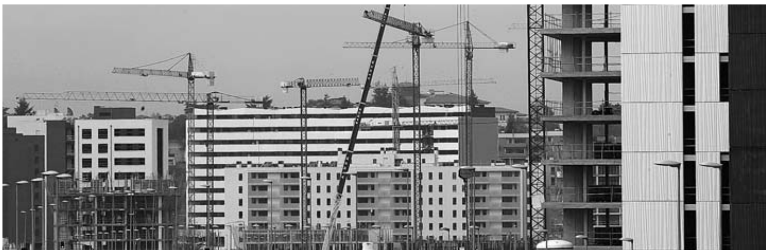
Edificios de viviendas libres y protegidas en construcción en el nuevo desarrollo de Erripagaña.
