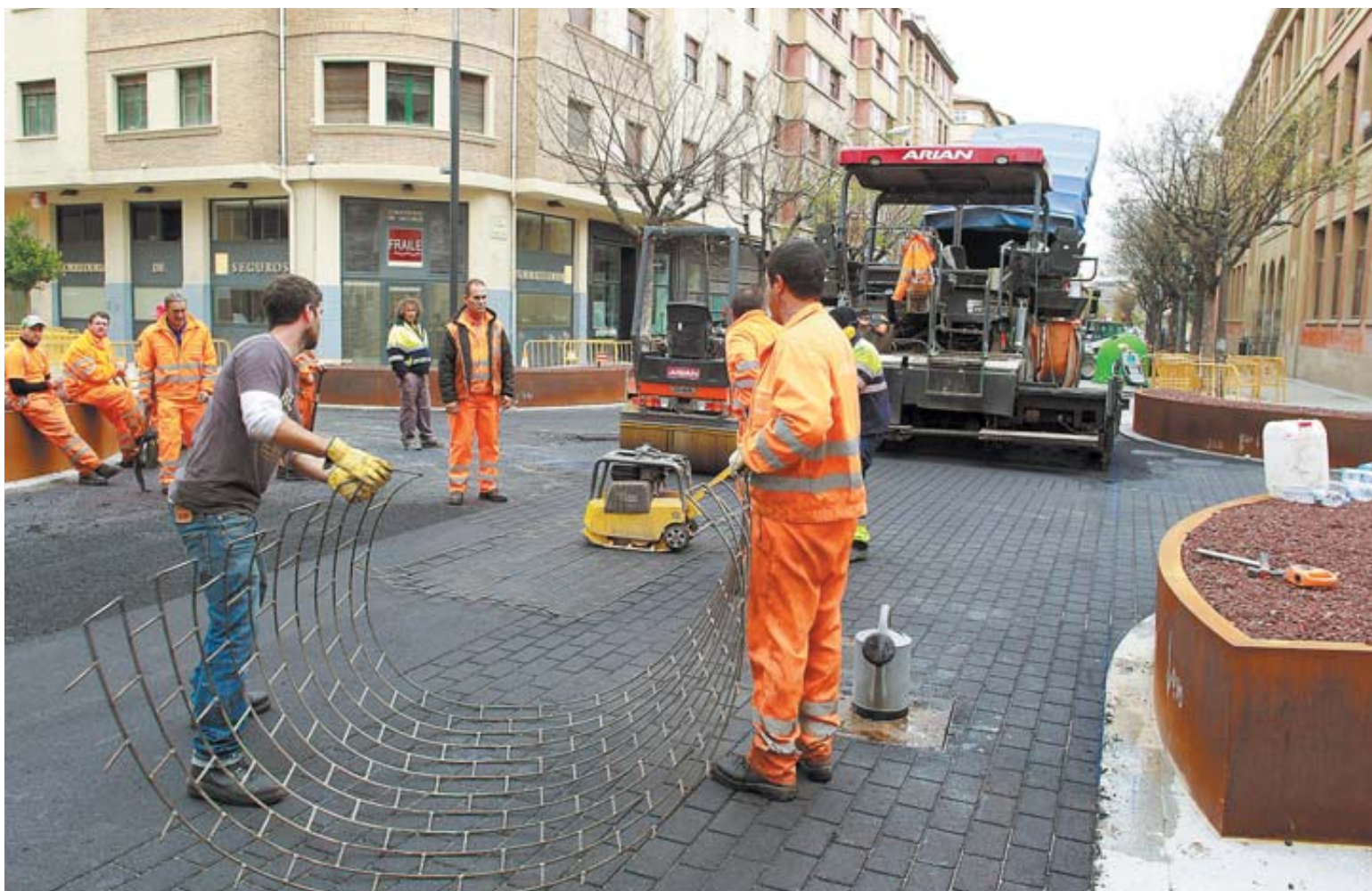
Dos operarios colocan la malla que simula los adoquines sobre el asfalto para que la pequeña apisonadora dé el toque final.
