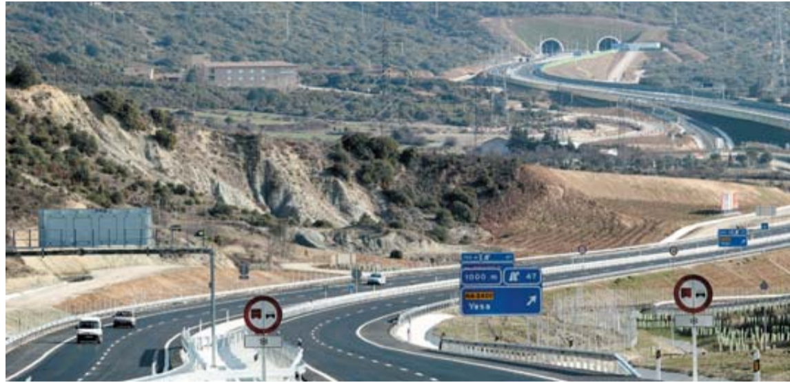
Último tramo de la autovía del Pirineo en Navarra, abierto al tráfico el pasado enero.
