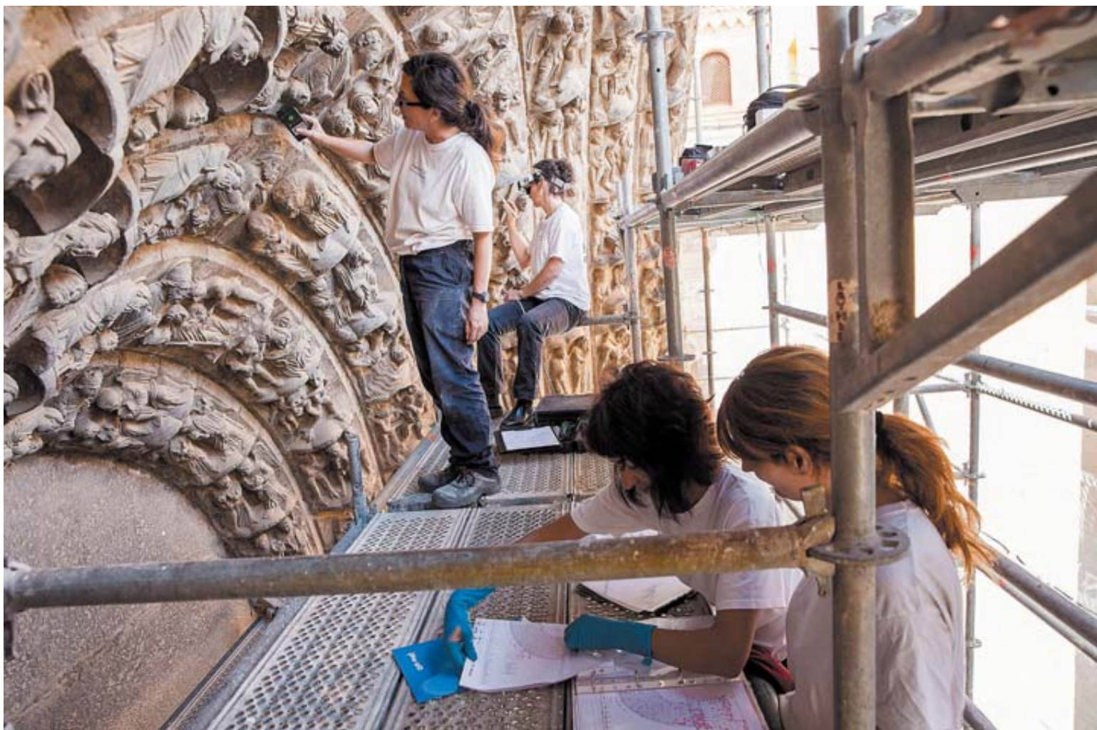
Varios restauradores trabajan en la piedra del pórtico, que sufre un grave problema de deterioro y suciedad.
