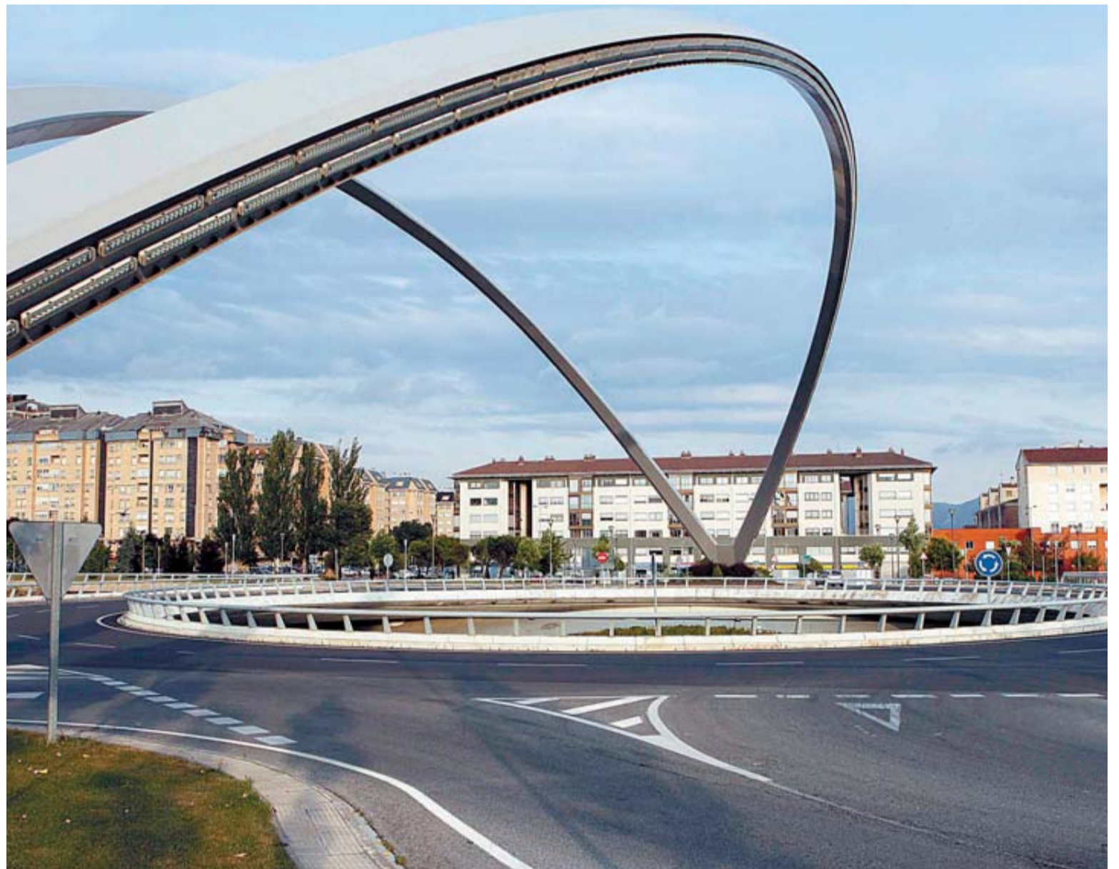
El arco sobre la Autovía del Camino, con edificios de viviendas de Zizur Mayor al fondo.
