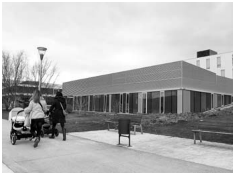
El nuevo centro se encuentra junto al lago de Sarriguren.
