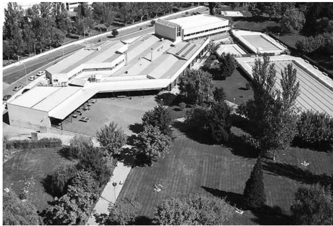
Vista aérea de las instalaciones deportivas de Lagunak, en Barañáin.
