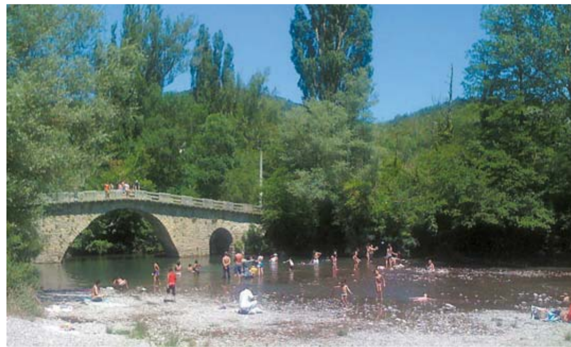
Vista del puente de Iturgaiz, de camino a Sorauren, durante el día de ayer.
