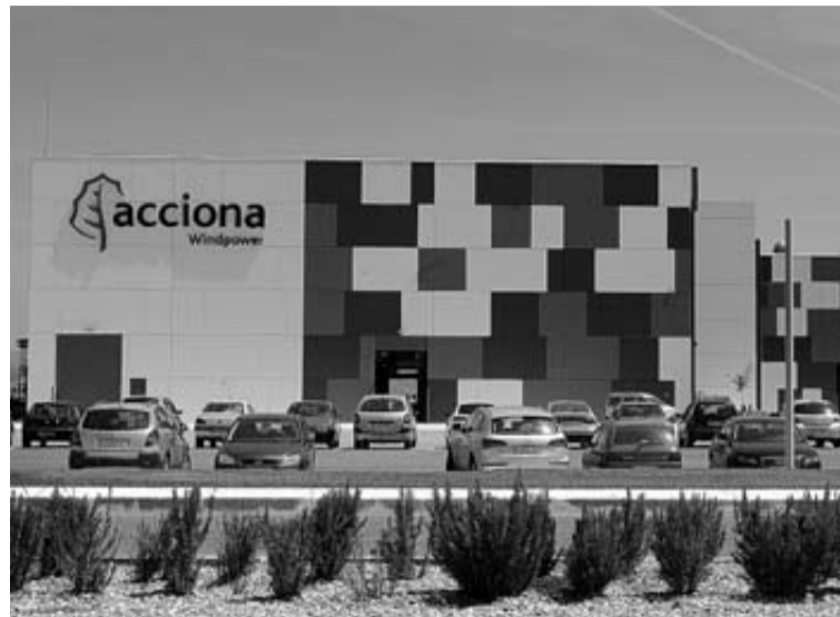
La planta de palas de Acciona Windpower en Lumbier.
