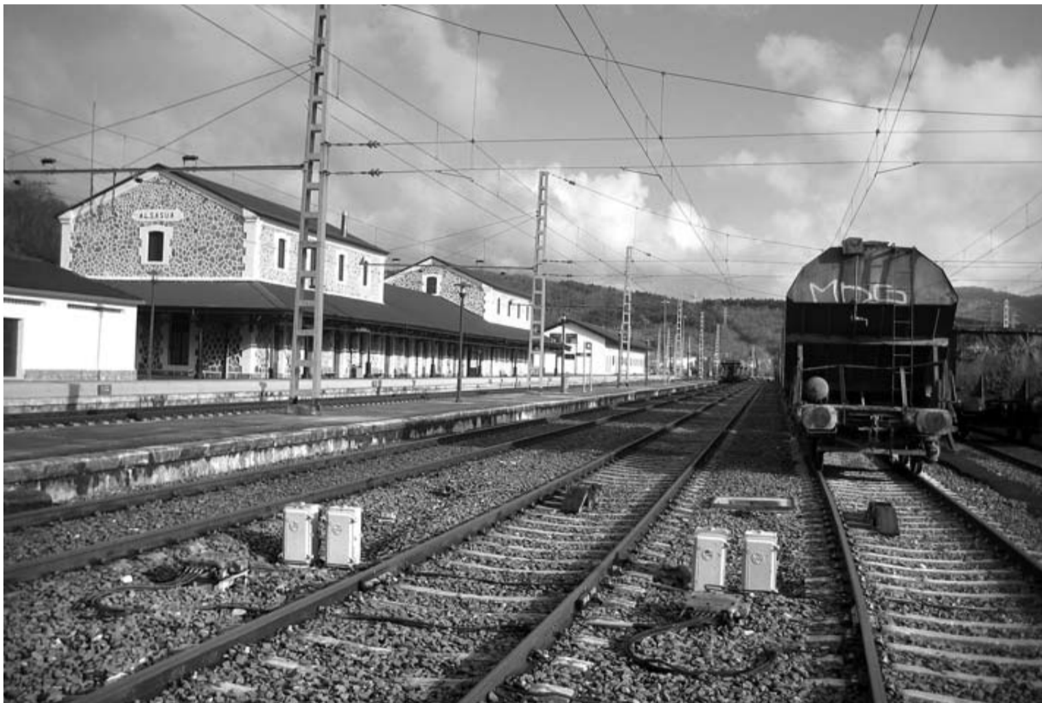
Aspecto parcial del entramado de vías del nudo ferroviario que representa la estación de Alsasua.
