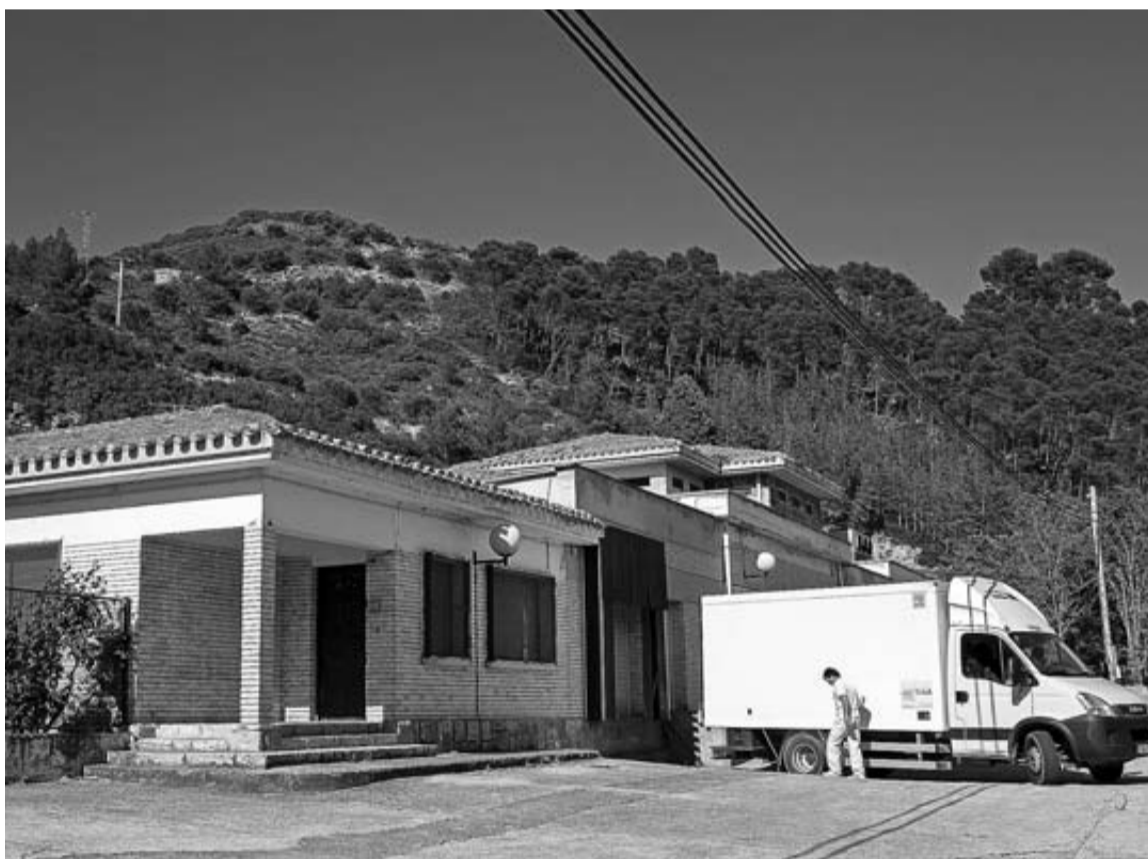
El matadero de Estella está situado en la antigua carretera de salida a Pamplona.
