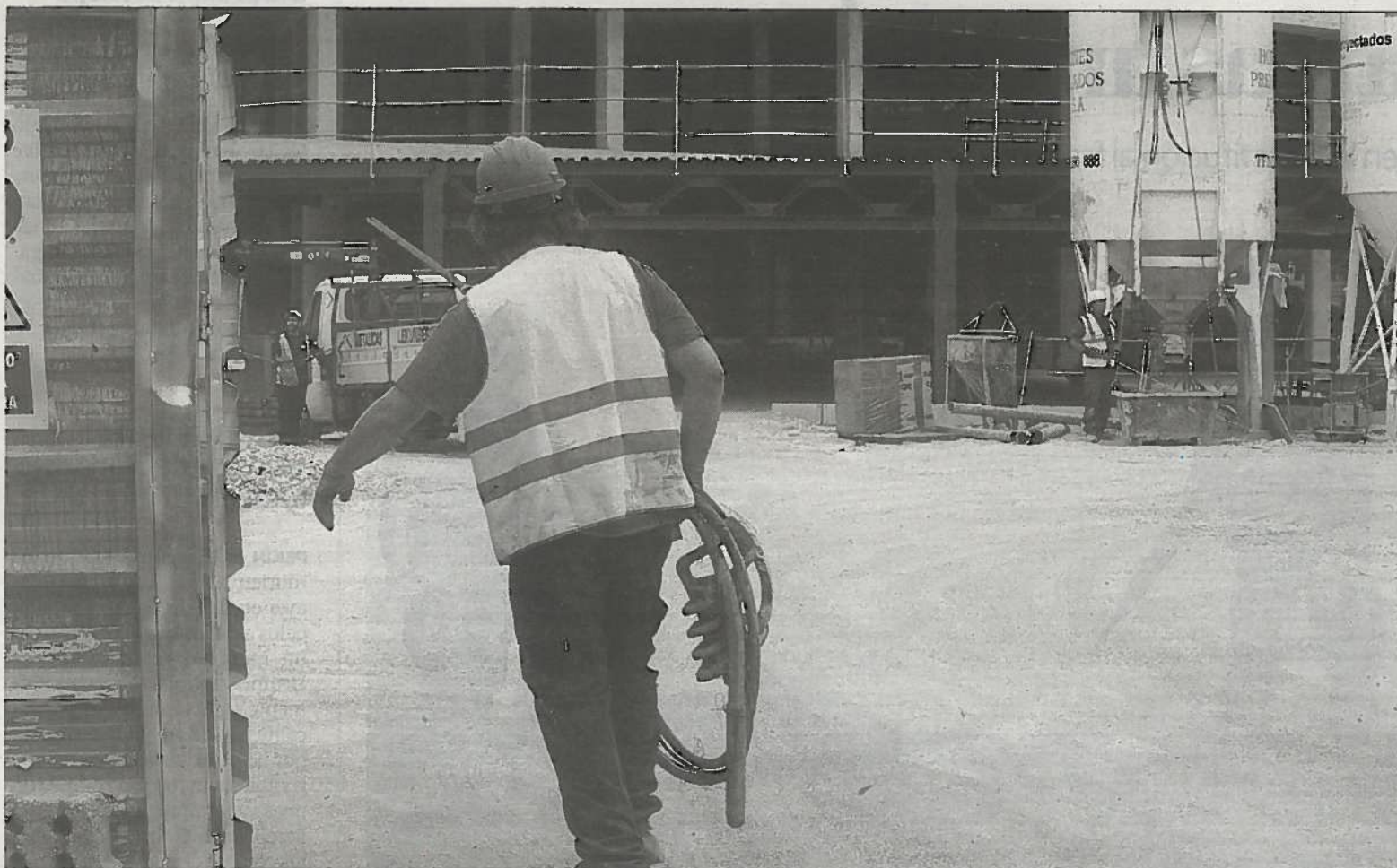
Dos trabajadores de la construcción en una obra. Foto: Diario de Noticias
