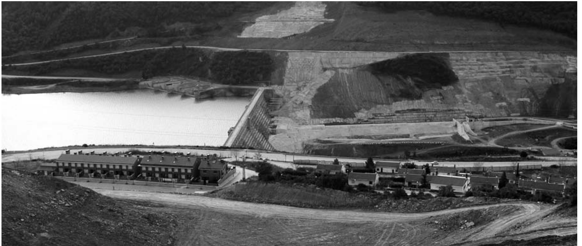
Desde la izda.: casas de la urbanización Mirador de Yesa, presa del embalse, y casas de la urbanización Lasaitasuna. Vista desde la zona superior de la ladera inestable excavada. CALLEJA/ARCHIVO
