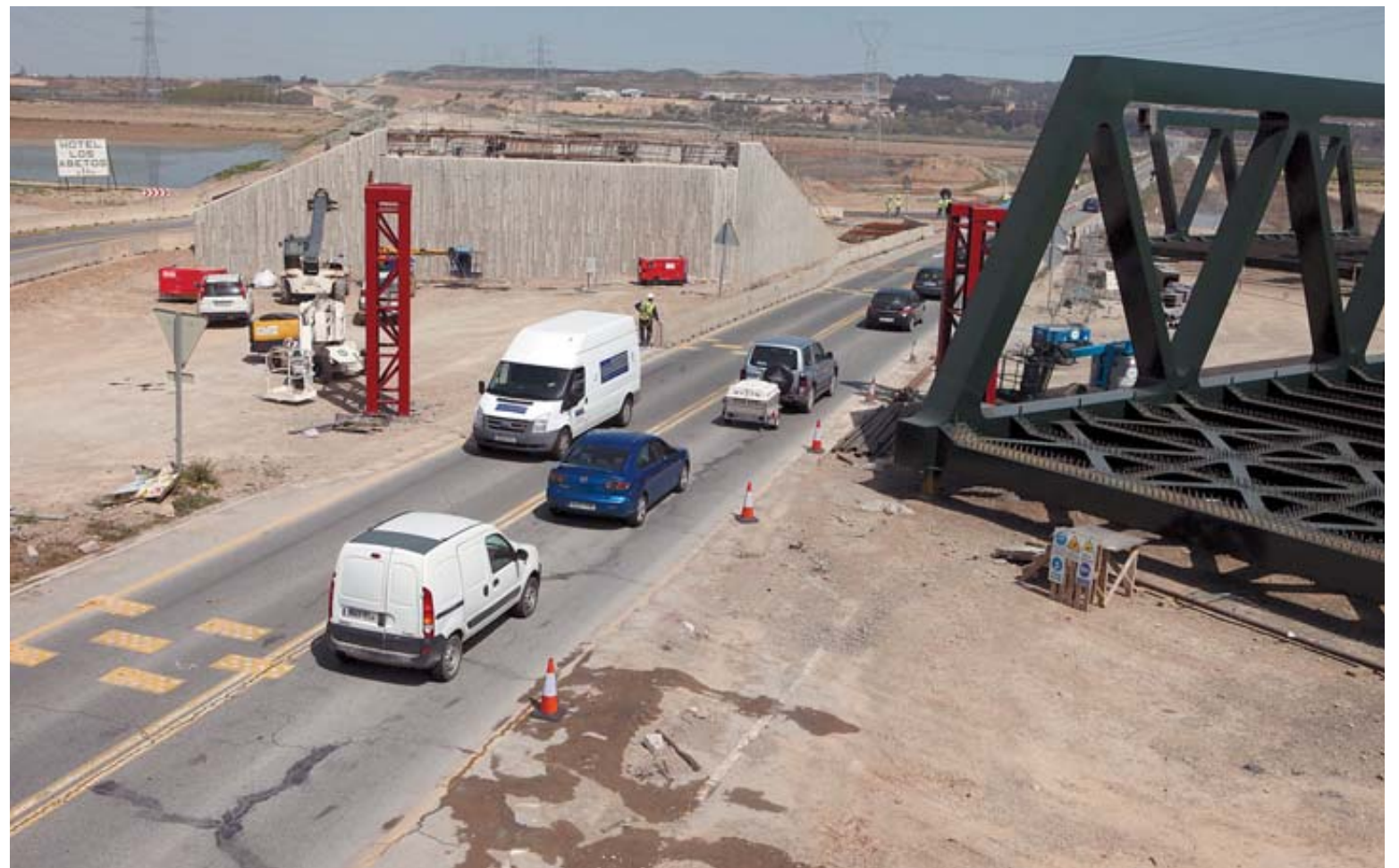
Imagen de las obras del Tren de Alta Velocidad (TAV) a la altura de Los Abetos, en el N-113.
