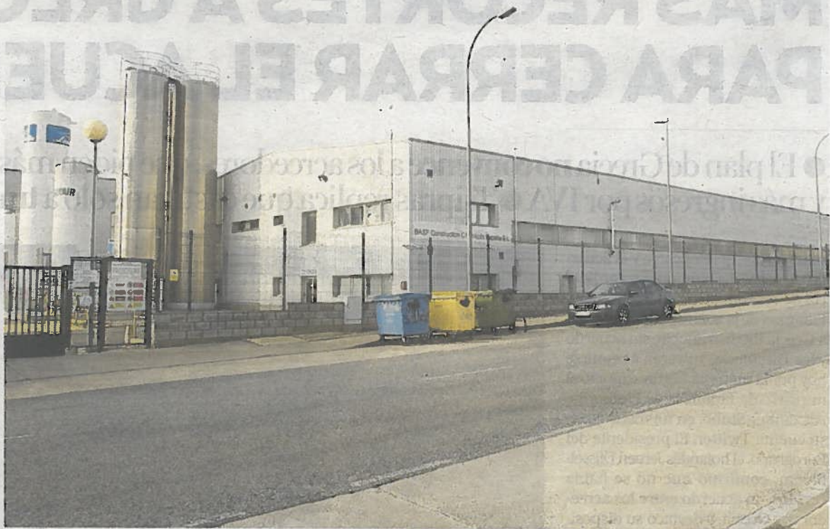
Vista exterior de la planta de BASF, ubicada en el polígono Las Labradas. Foto: J.A. Martínez
