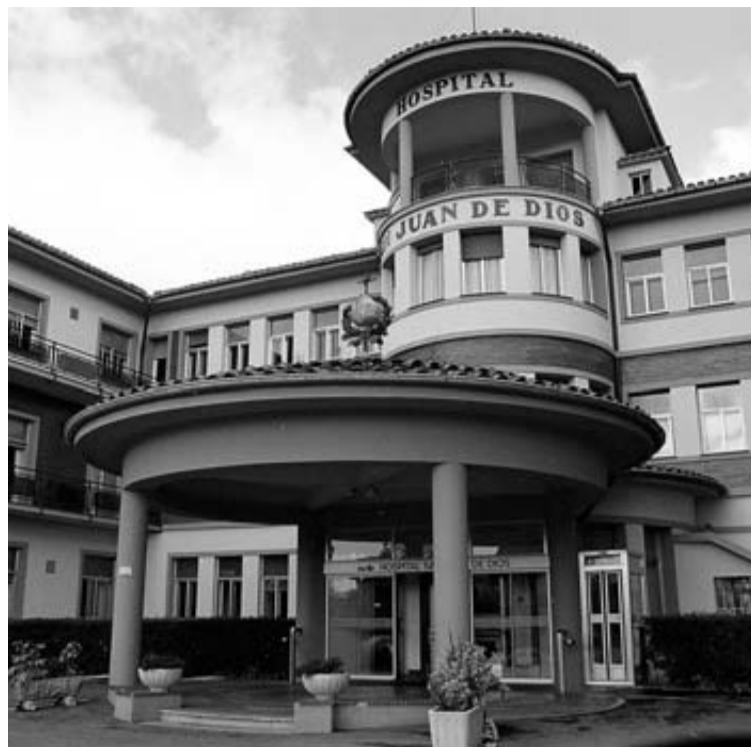
Acceso al hospital San Juan de Dios
