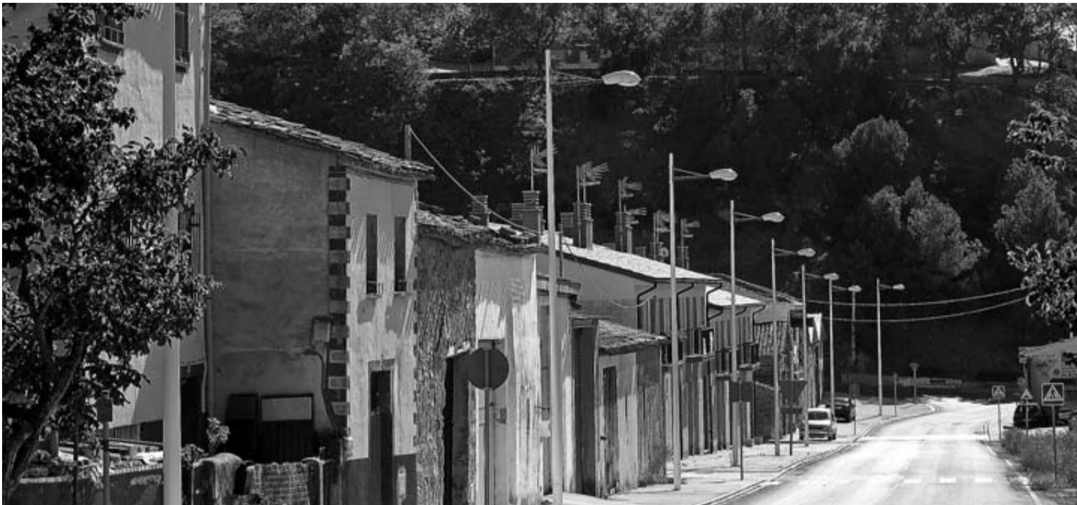
Vista del alumbrado público recién renovado a la entrada de Sesma viniendo desde Estella.
