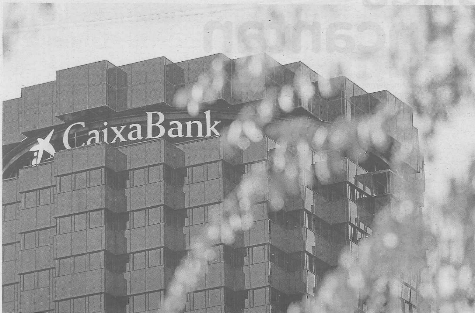
La fachada de las oficinas de CaixaBank en Barcelona. Foto: D.N.
