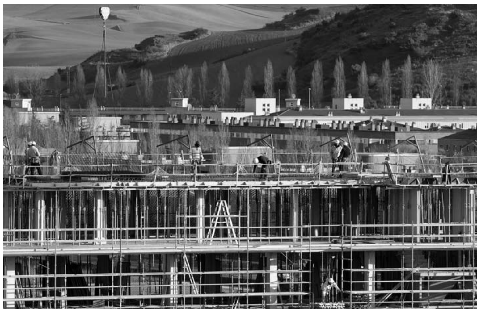
Edificio de viviendas protegidas en construcción en Erripagaña.
