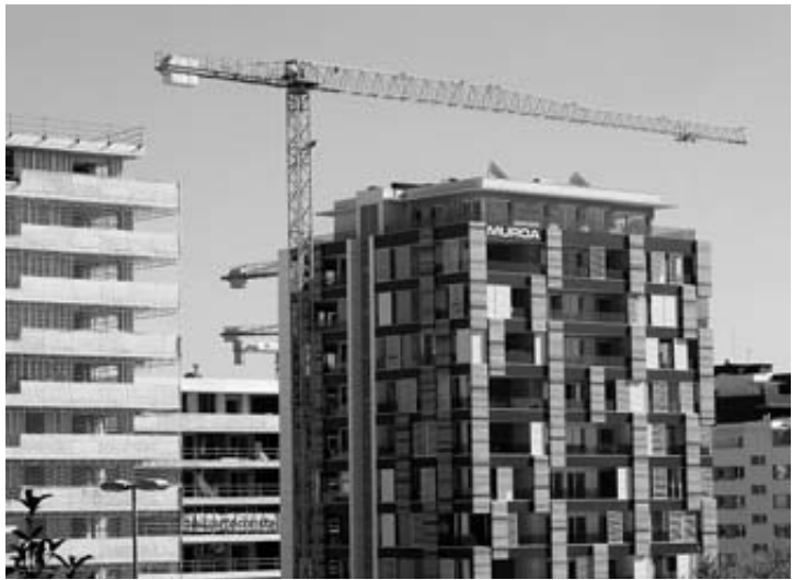
Viviendas en construcción en Lezkairu, Pamplona.
