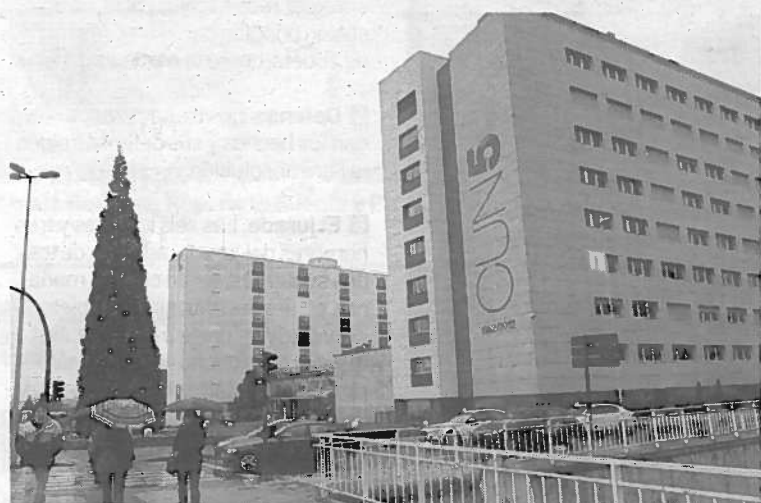
Exterior de la CUN. DN
