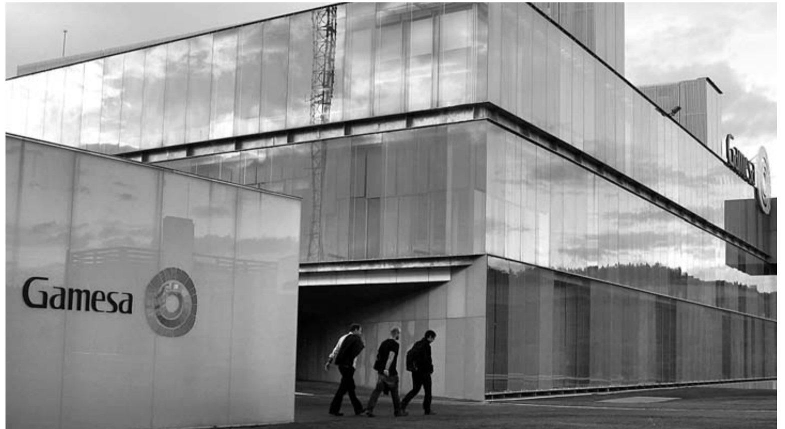
Tres empleados, ayer, abandonando las instalaciones de Gamesa en la Ciudad de la Innovación (Sarriguren).
