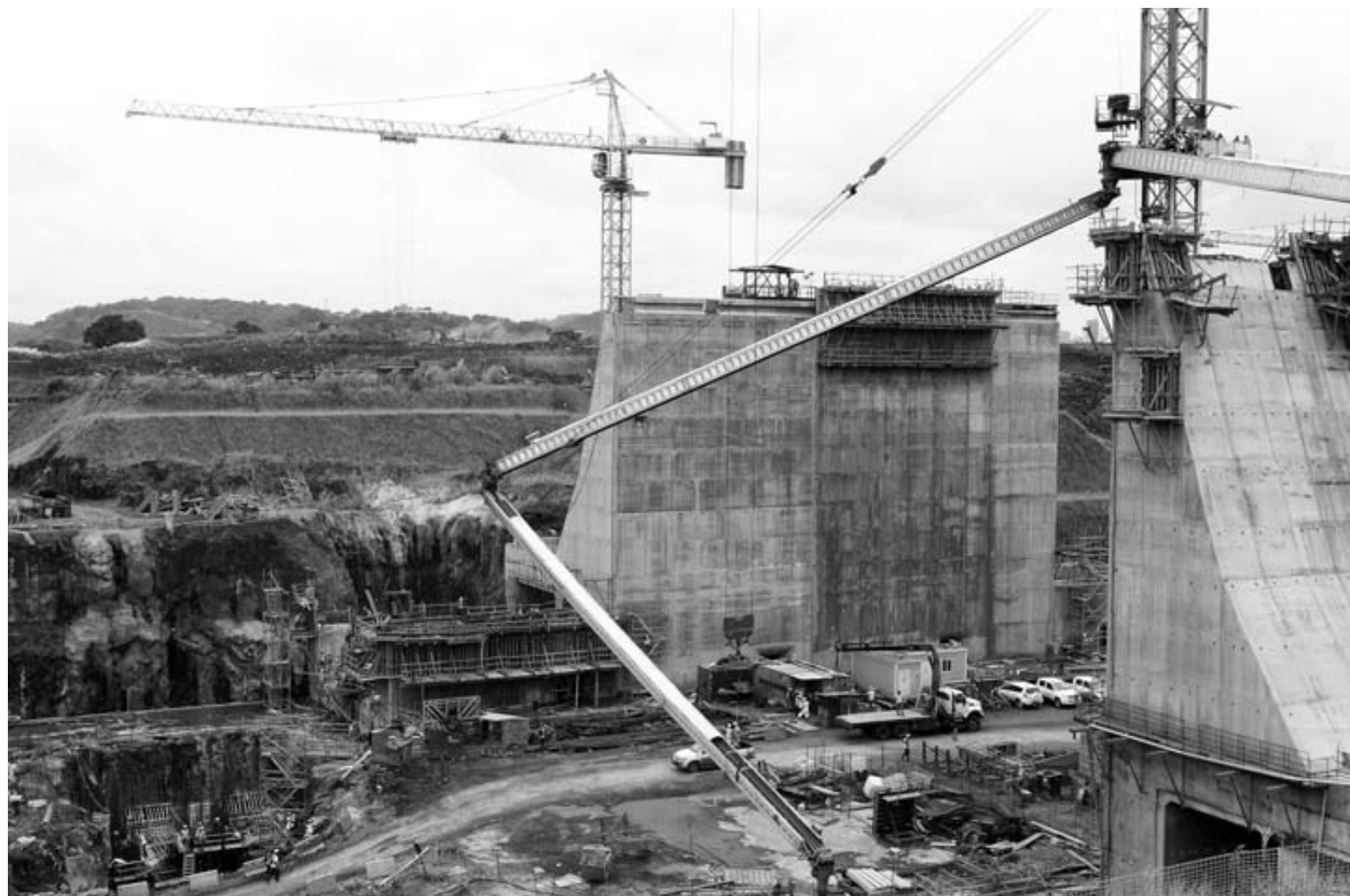
Fotografía de archivo (04/10/2012) de las obras de la ampliación del Canal de Panamá a cargo del consorcio GUPC, liderado por Sacyr.
