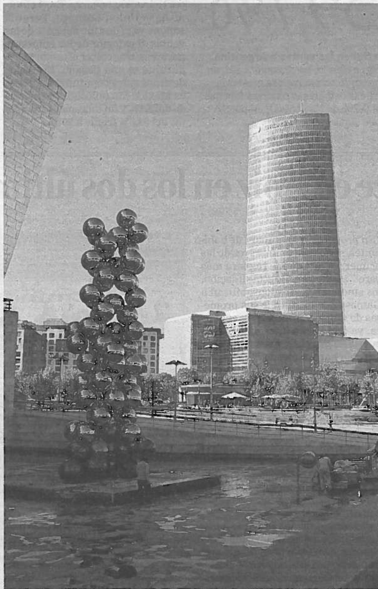
La Torre Iberdrola se alza ya concluida en Bilbao. FOTO: D.N.
