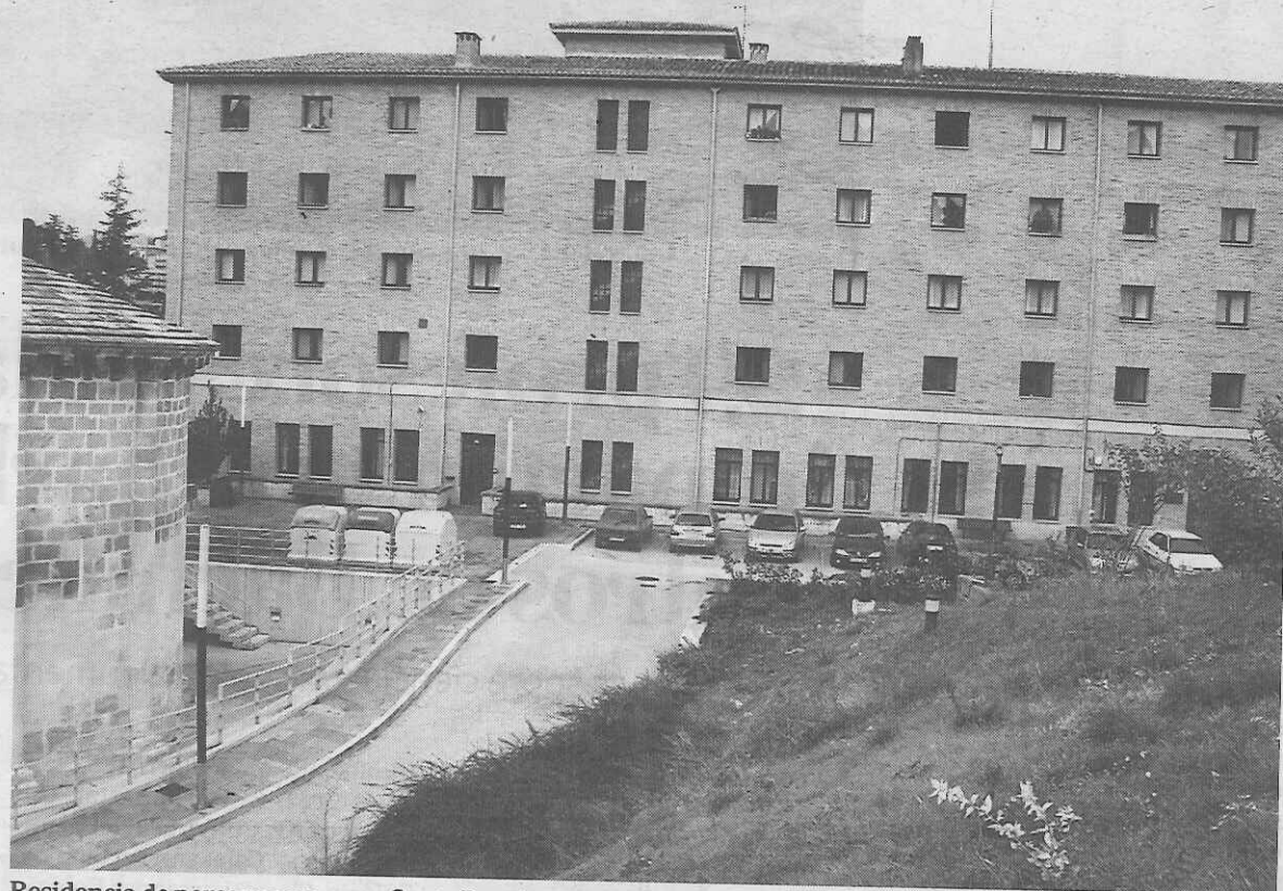
Residencia de personas mayores Santo Domingo de Estella, primera que construye apartamentos adyacentes.
