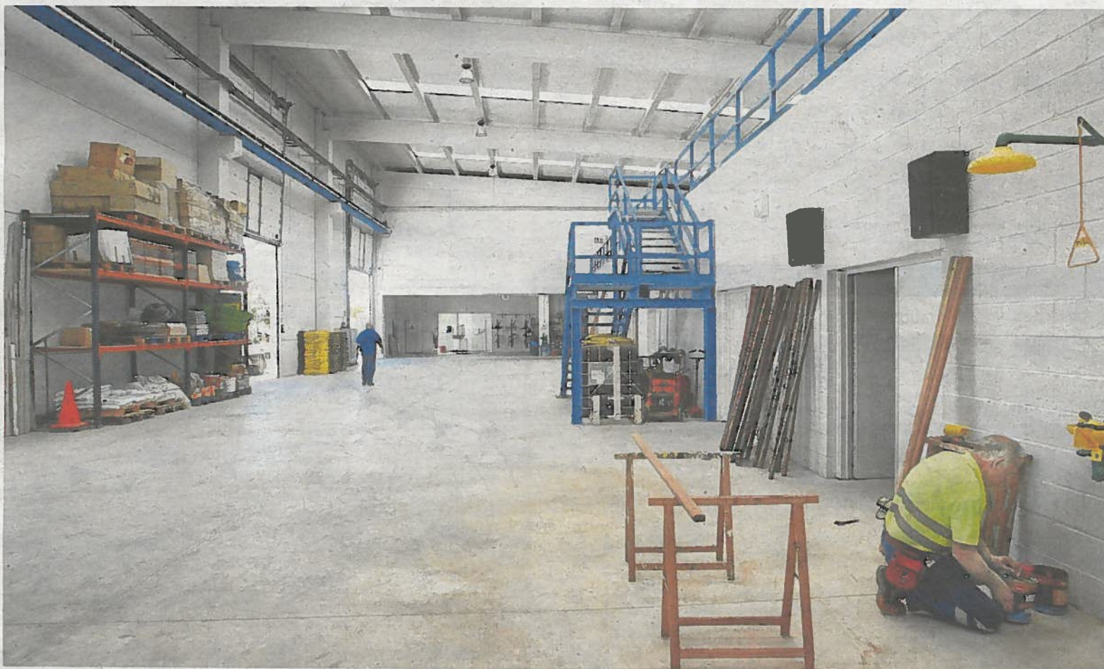
Operarios trabajan ayer en la nave de servicios múltiples, que comparte edificio con la sede de la escuela taller burladesa. FOTO: OSKAR MONTERO
