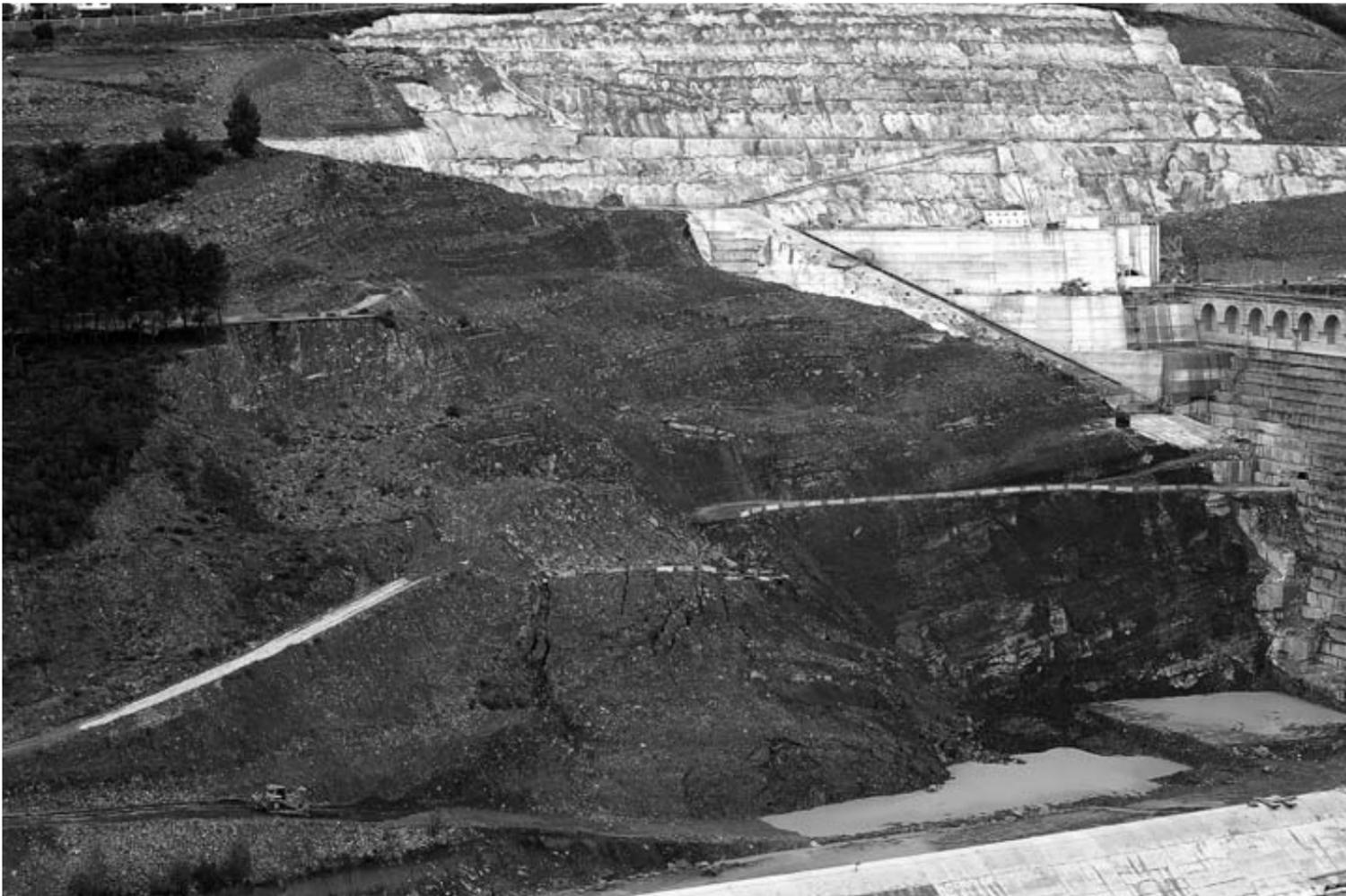
**EL TALUD, CASI SIN TOCAR** Desde el derrumbe del pasado martes, apenas se ha sellado una grieta superior para evitar la entrada de agua. Se estudian ahora fórmulas para corregirlo: si excavarlo todo o retirar sólo una parte del material.
