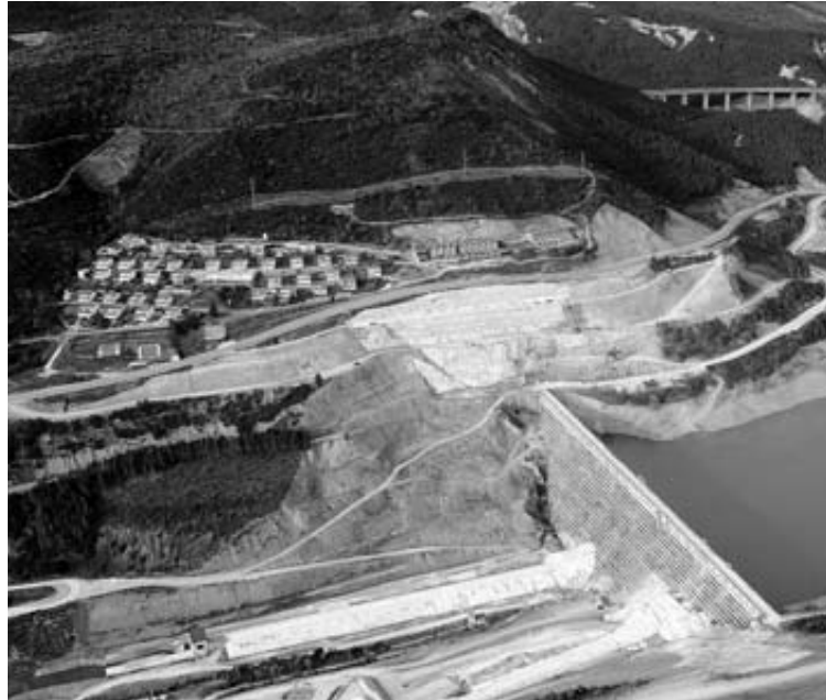
Urbanizaciones afectadas por el deslizamiento, junto a la presa. IVÁN BENÍTEZ
