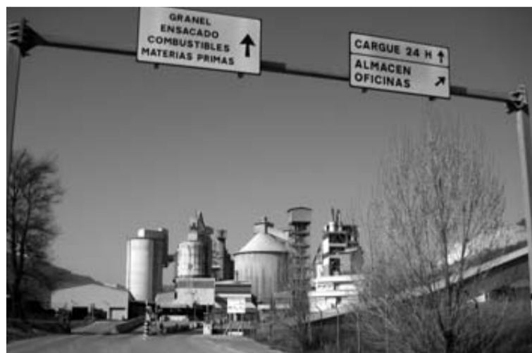
Planta de Olazagutía de Cementos Portland.
