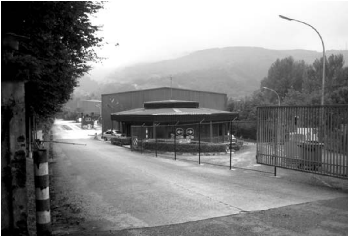
Acceso a la fábrica de tubos de acero Zalain en Lesaka.
