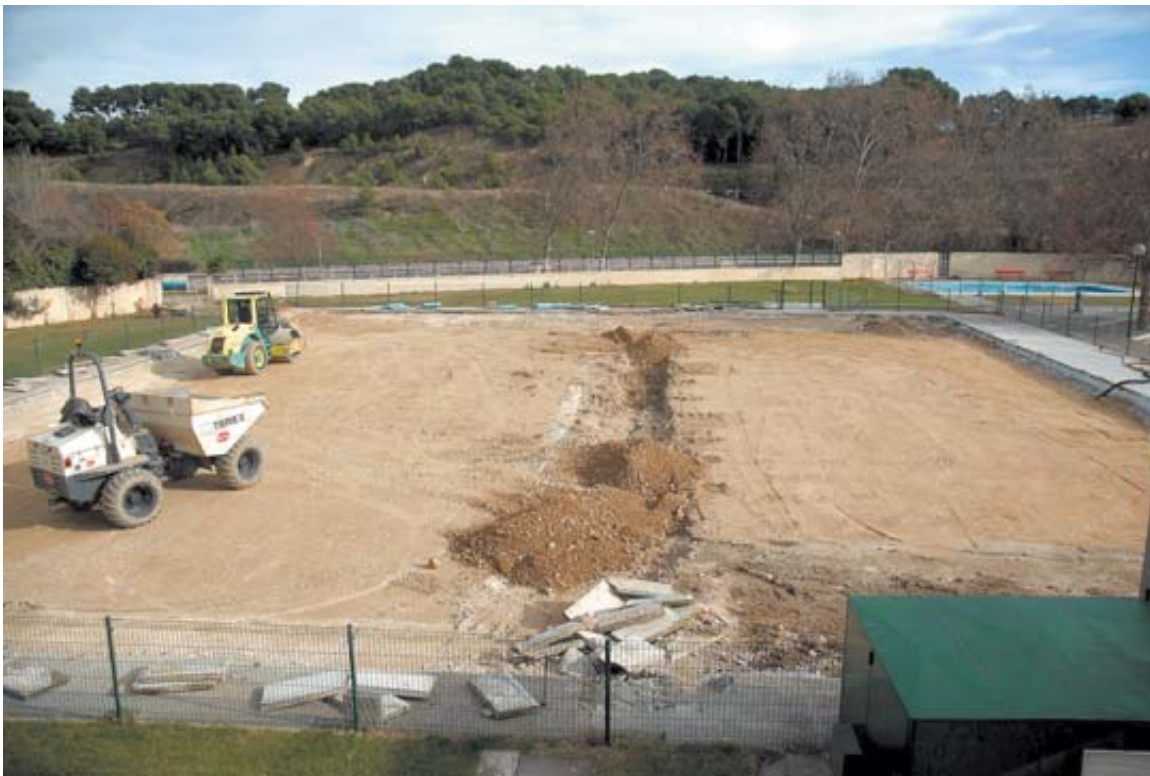
Trabajos de sellado de las antiguas piscinas del Ereta.
