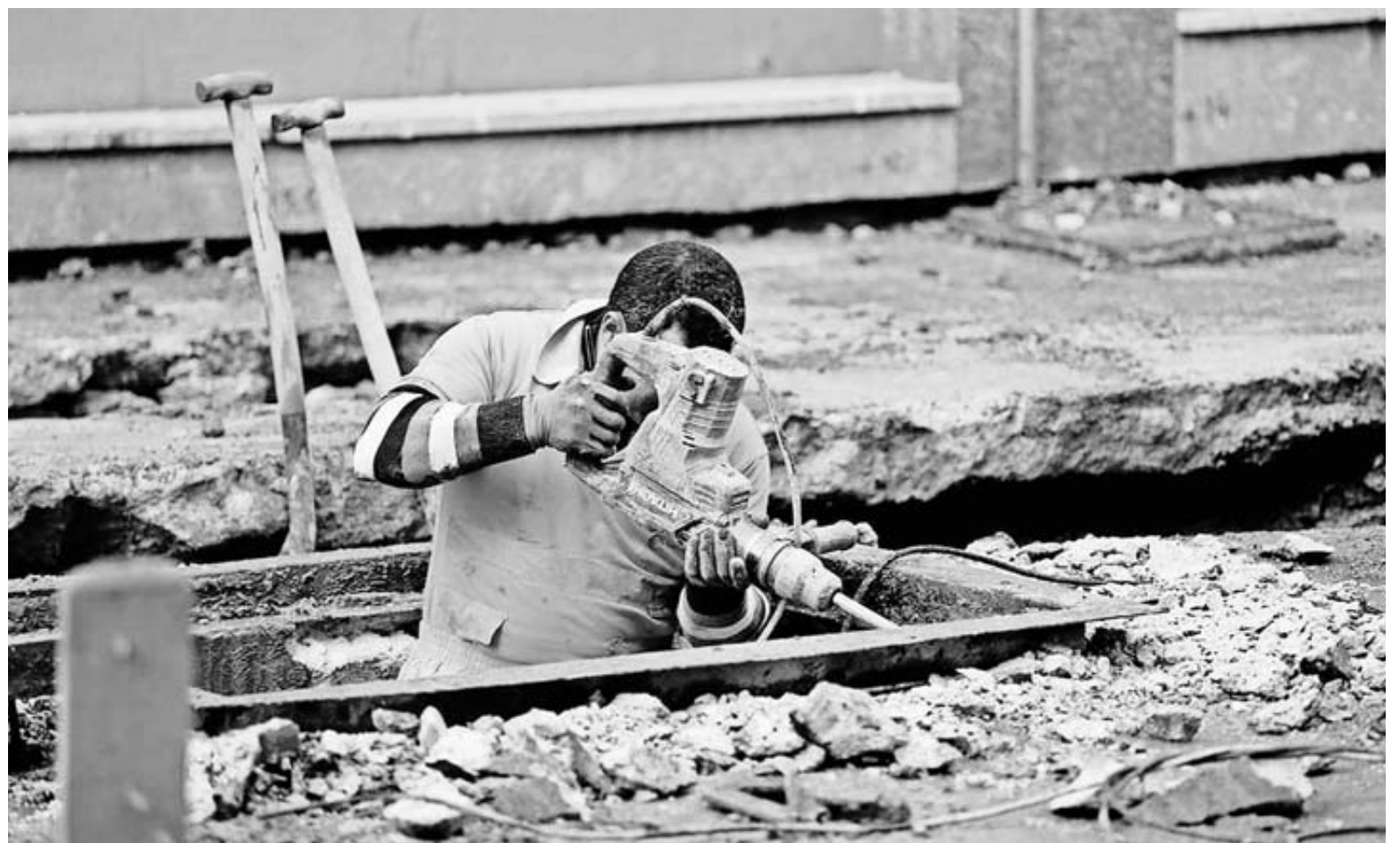
Un trabajador realiza obras de asfaltado en una calle.
