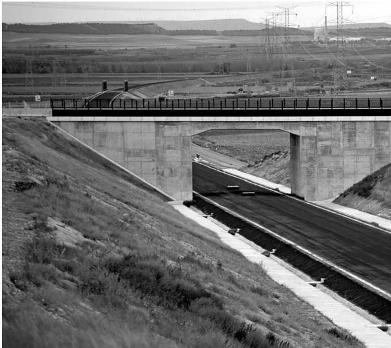
Plataforma, ya acabada, del tramo del corredor ferroviario de alta velocidad en Cadreita.
