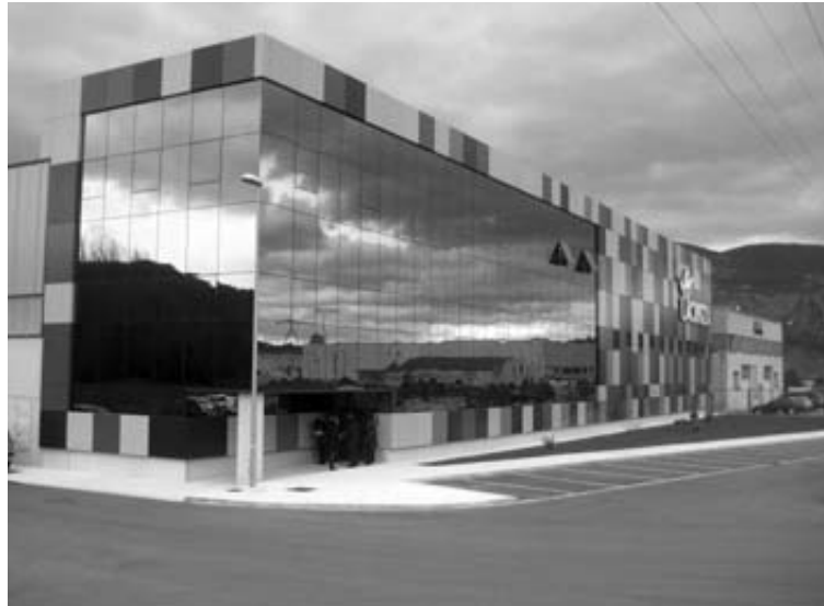
Sede de Lakunza Kalor Group S.A.L.
