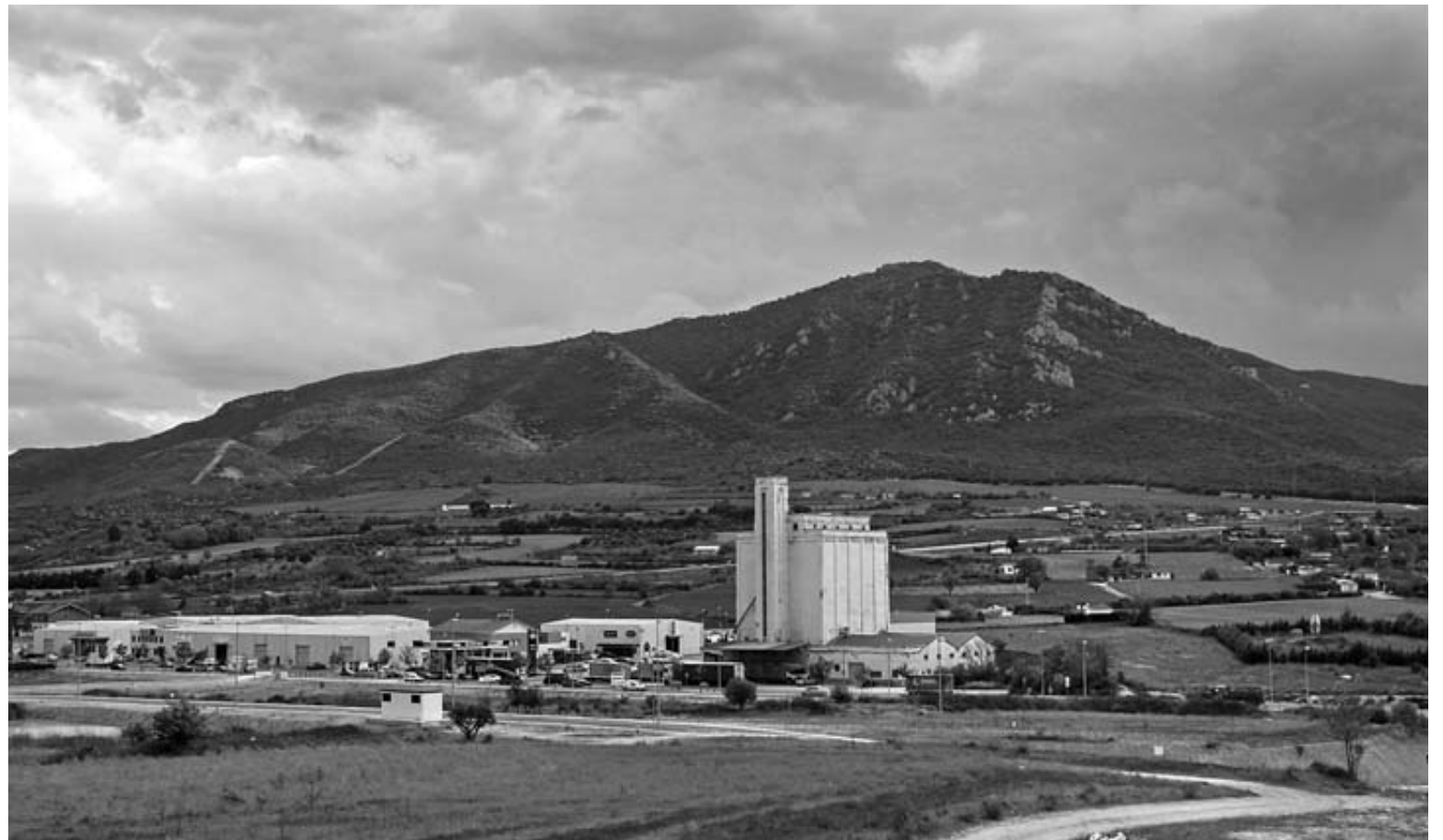
Una imagen tomada desde la parcela sobre la que se construirá el supermercado de Mercadona, que tendrá unos 1.500 m 2 .
