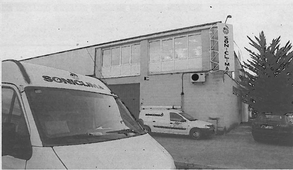
Nave de Soniclíma en el polígono de Mutilva Baja. FOTO: JAVIER BERGASA
