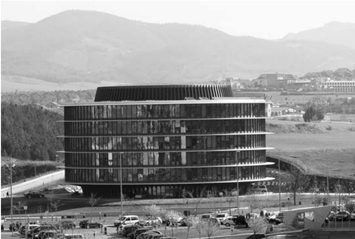
Edificio de oficinas de Gamesa en la Ciudad de la Innovación de Sarriguren.
