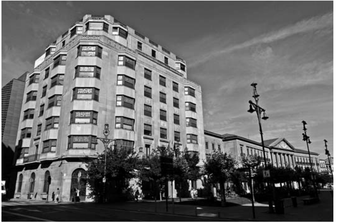
Imagen del Palacio de Navarra (dcha) y del edificio de la Hacienda Foral.
