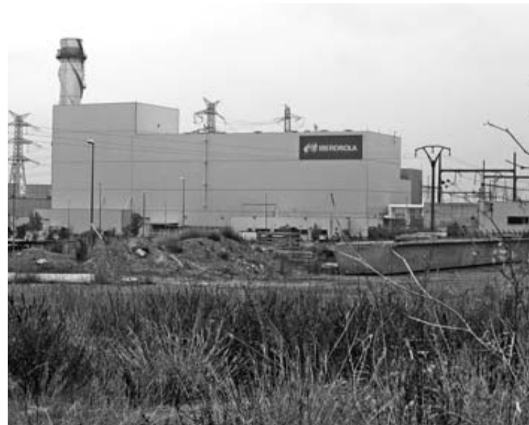
Vista de la central térmica de Iberdrola en Castejón, que se quiere ampliar al doble de su potencia. NURIA G. LANDA
