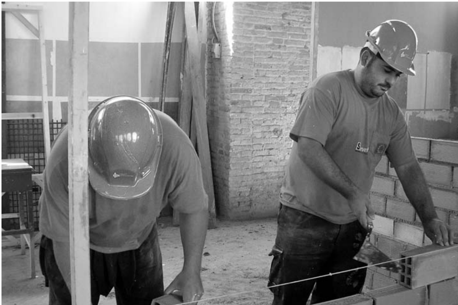
Dos alumnos realizan trabajos de albañilería durante uno de los cursos que organiza la Fundación Laboral de la Construcción.
