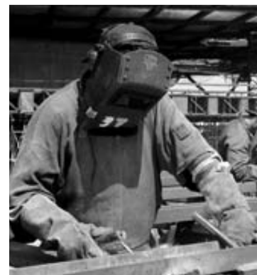
Trabajos de soldadura.
