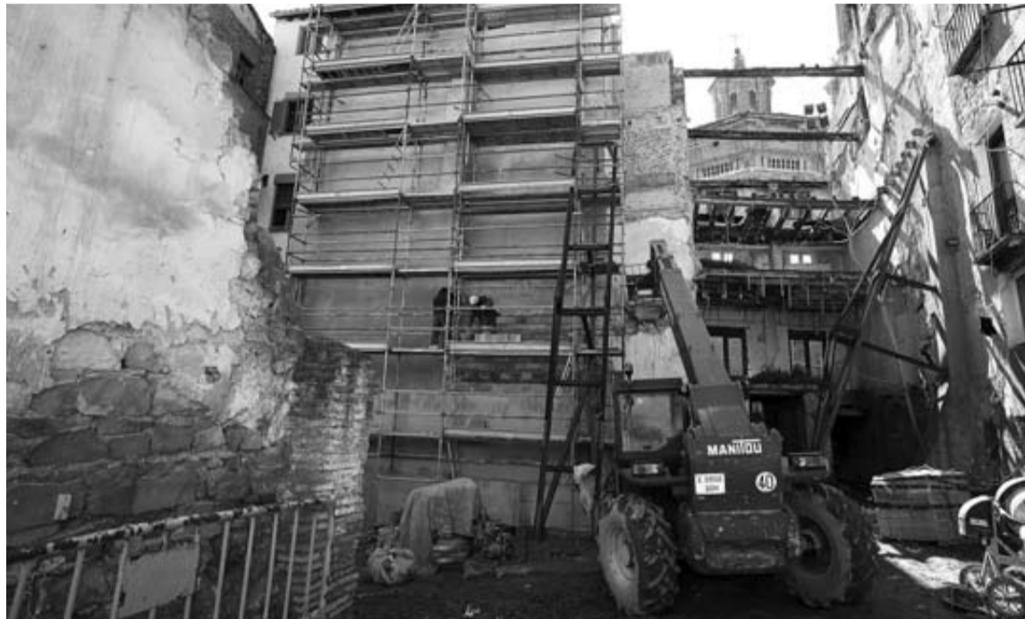
Obras de rehabilitación en un edificio del Casco Viejo de Tudela.
