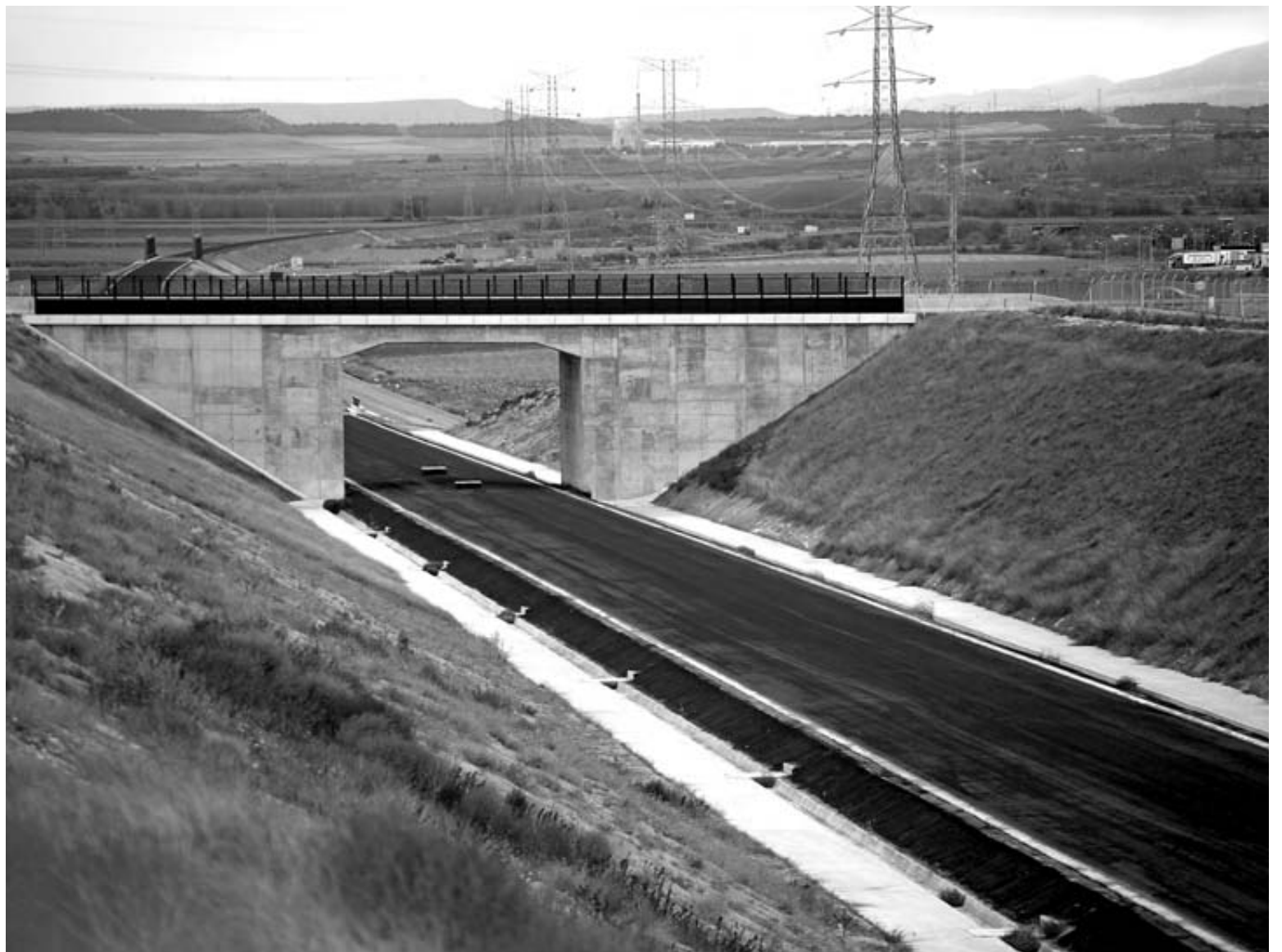
En la imagen, la plataforma del TAV ya ejecutada en Cadreita, junto a la autopista AP-68, una obra que se paralizó en 2013.
