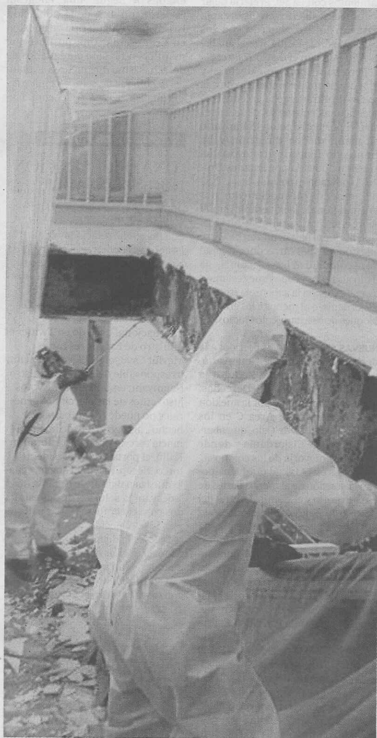
Operarios desmontan placas aislantes de material con amianto. Foto: D.N.
