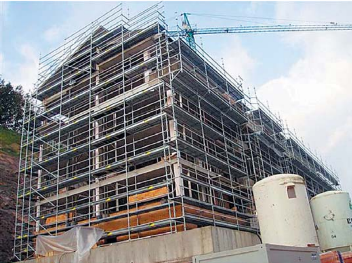
Una de las muchas construcciones paralizadas debido a la crisis.
