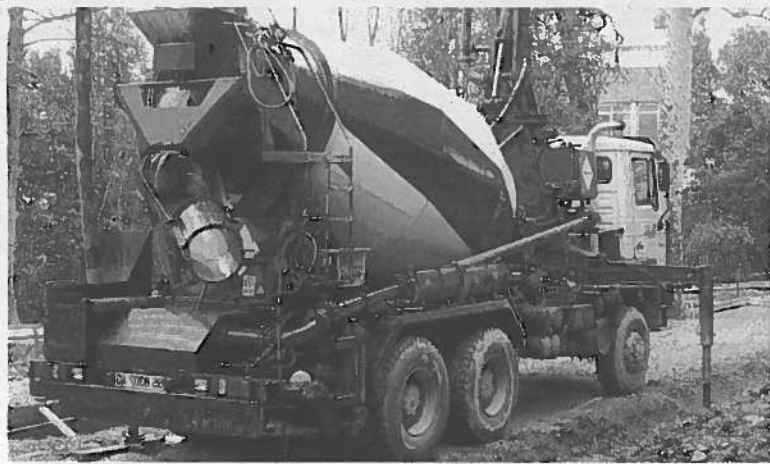
Un camión hormigonera, en una obra. FOTO: ARCHIVO
