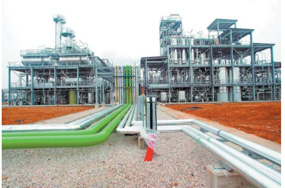
La planta de producción de biodiésel que Acciona inauguró en 2005 en Caparroso.
