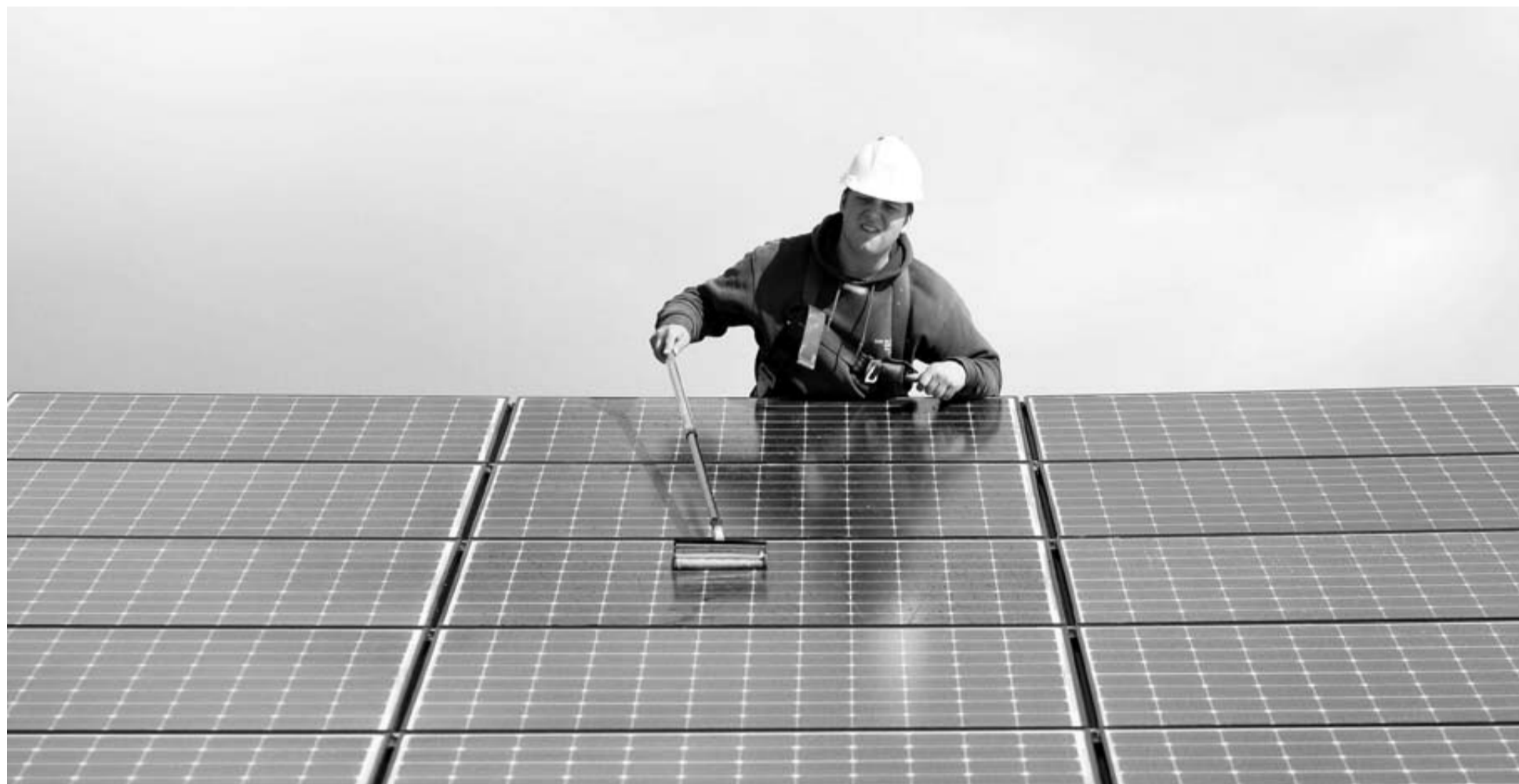
Un hombre realiza tareas de mantenimiento en una instalación solar.
