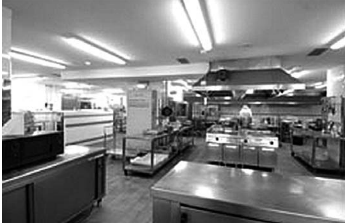
Nuevas cocinas del Complejo Hospitalario de Navarra.
