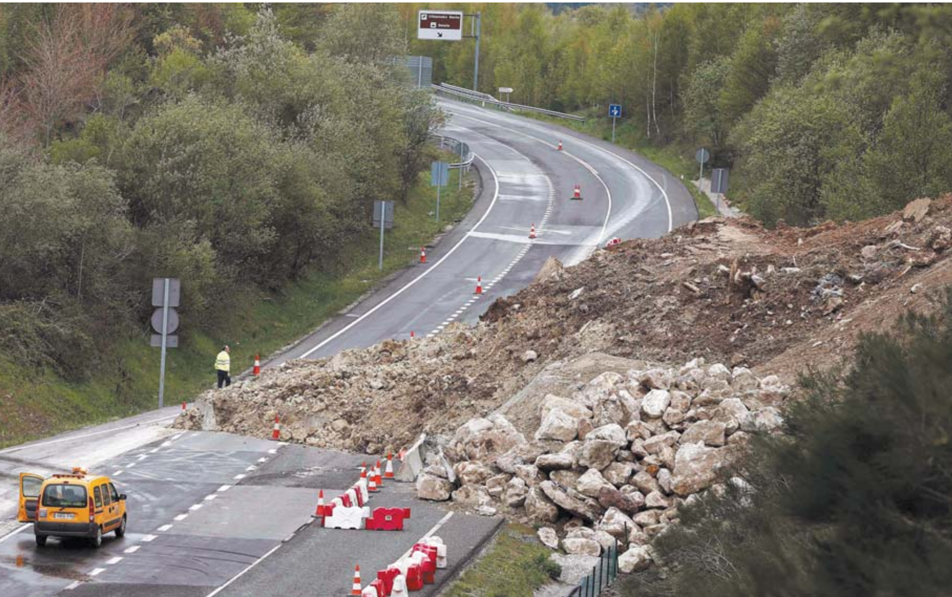
La ladera de la salida del túnel sentido Pamplona cedió ayer a las 10.40 horas, sin que se produjeran heridos.
