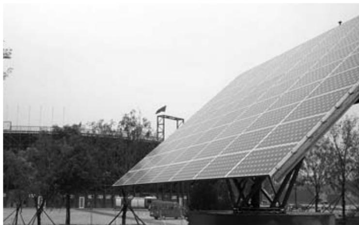
Paneles solares dotados de un seguidor de Mecasolar.
