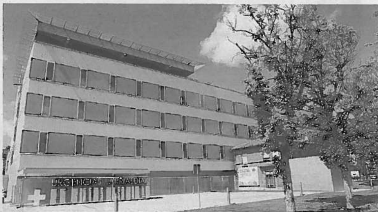
El nuevo edificio de Urgencias unificadas. Foto: Unai Beroiz
