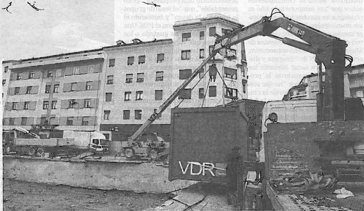
Las grúas retiraban ayer parte del vallado de las obras. FOTO: JAVIER BERGASA
