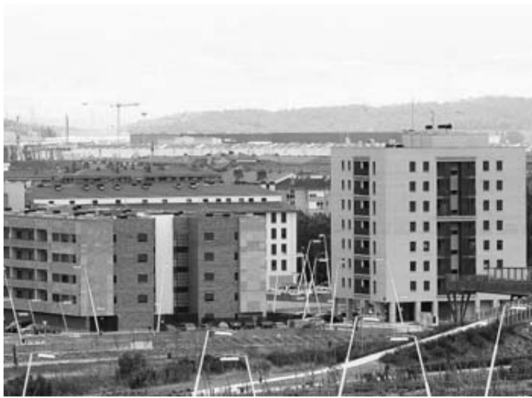
Edificios de viviendas nuevas en Artiberri.
