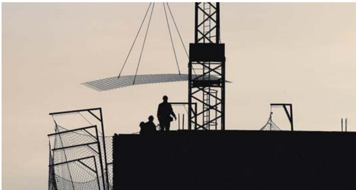
Obreros trabajan al atardecer en la construcción de un edificio de viviendas protegidas en Lezkairu. JAVIER SESMA
