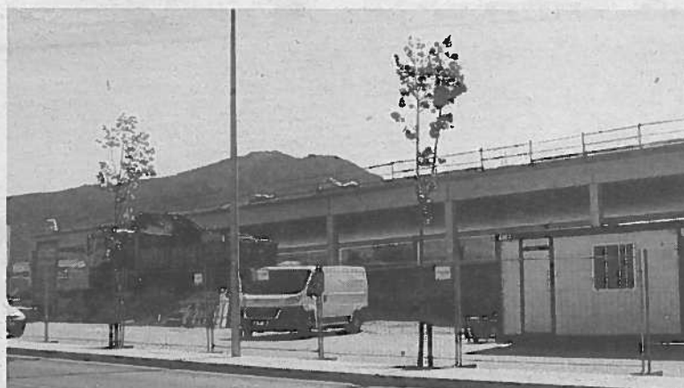
Edificio en construcción de la Escuela Taller en Merkatondoa. FOTO: C.S.
